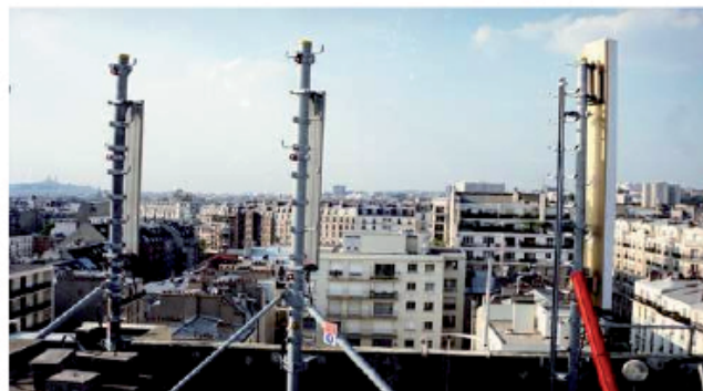
Des antennes-relais pour téléphonie mobile posées par France Télécom sur des immeubles parisiens août 2000. Crédits photo : Le Figaro
